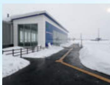
写真1 ロイズタウン駅前歩道の融雪状況
