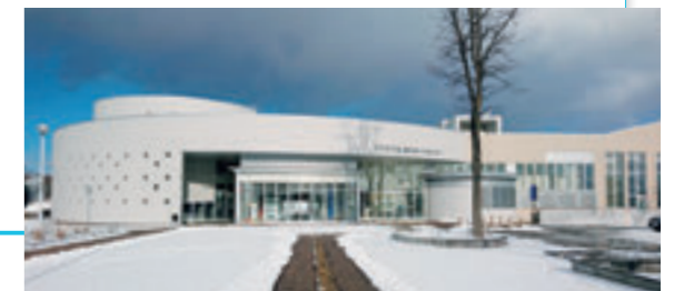
PPA方式で太陽光パネルを設置予定の沼ノ端スポーツセンター
