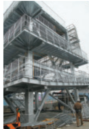
高知県安芸市の津波避難タワー。道内では雪や寒さへの備えが必要だ
