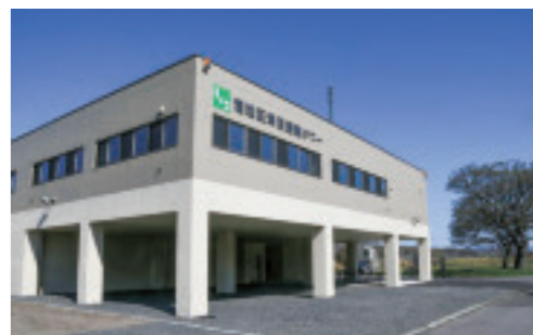
蘭越町の津波避難施設。釧路町は想定される津波に備えて1.5倍の3層構造とする
