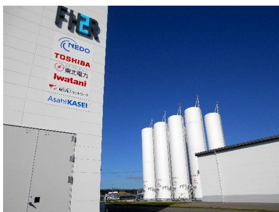
【FH2R外観（左手前が水素製造建屋、中央奥が水素ガス貯蔵タンク）】
