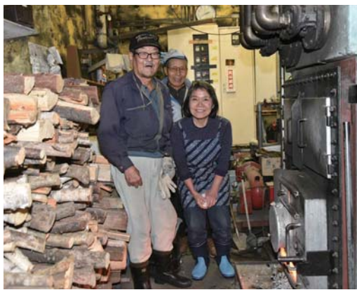
黄金湯を運営する渡辺由起子さんと、薪の調達・ボイラー作業を手伝う町民
