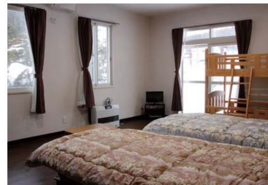
改修中のシェアハウス
