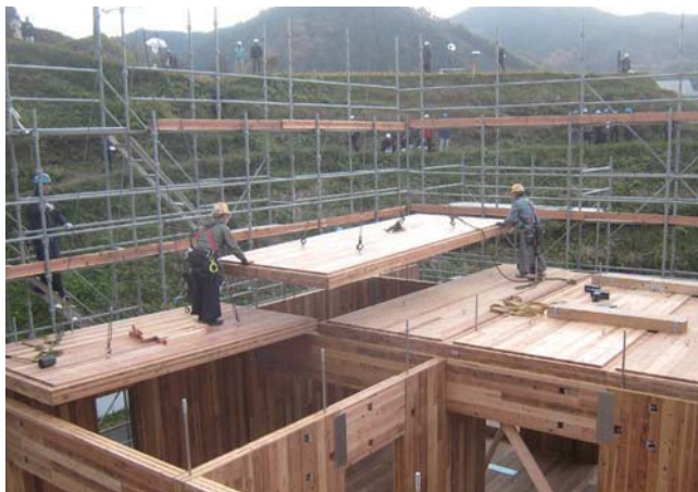
大豊町に建設された高知おとよ製材社員寮(左上)と、CLTパネルを使った建設工事の様子(左下) 大豊町は急傾斜地が多く、狭い平地に棚田が並ぶ(右)
